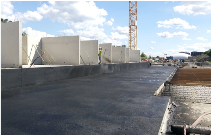
Betongdekket ved Grefsen Stasjon sprøytes for vanntetting. (Foto: Pazkar Nor)
